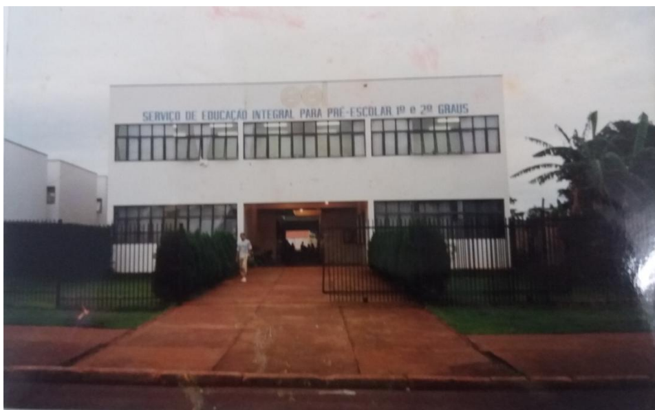
Figura 6 – Fachada do prédio próprio da Escola SEI, 1993
