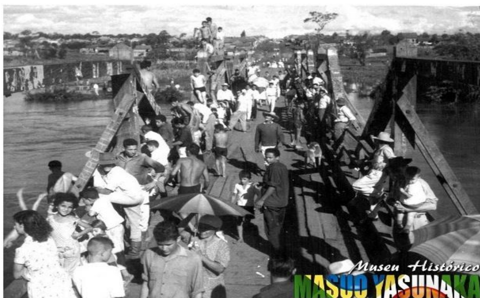
Figura 5 - Ponte sobre o Rio Dourados (1954)
