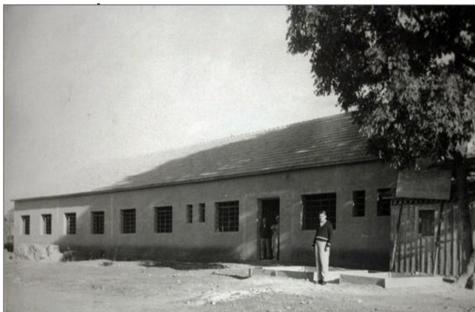
Figura 18 – Prédio do Instituto, em fase de acabamento (1966)
