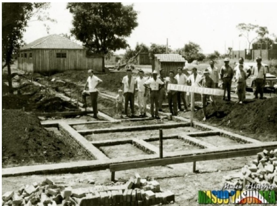
Figura 17 -Construção do Instituto D. Pedro II (década de 1960)
