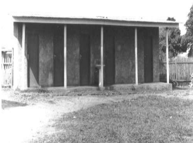
Figura 87. Novos banheiros do Grupo Escolar Tenente Aviador Antônio João, 1974. Fonte: Arquivo da Escola Estadual Tenente Aviador Antônio João.
