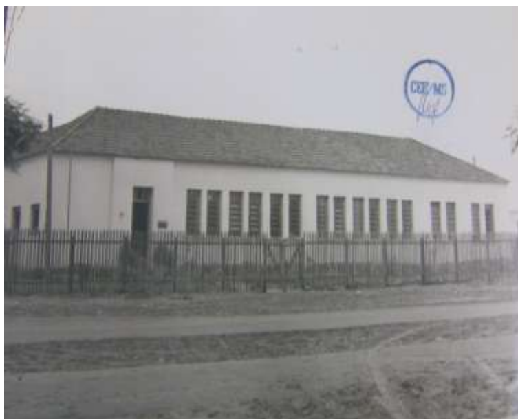
Figura 19. Fachada do Grupo Escolar Tenente Aviador Antônio João, 1974. Fonte: Arquivo da Escola Estadual Tenente Aviador Antônio João.
