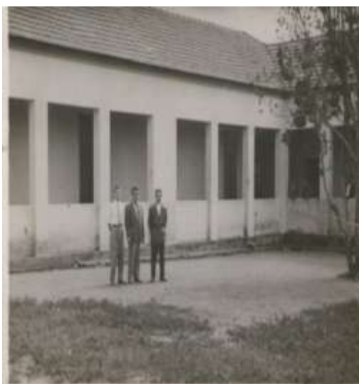
Figura 82. Parte Interna do Grupo Escolar Tenente Aviador Antônio João em 1959.
