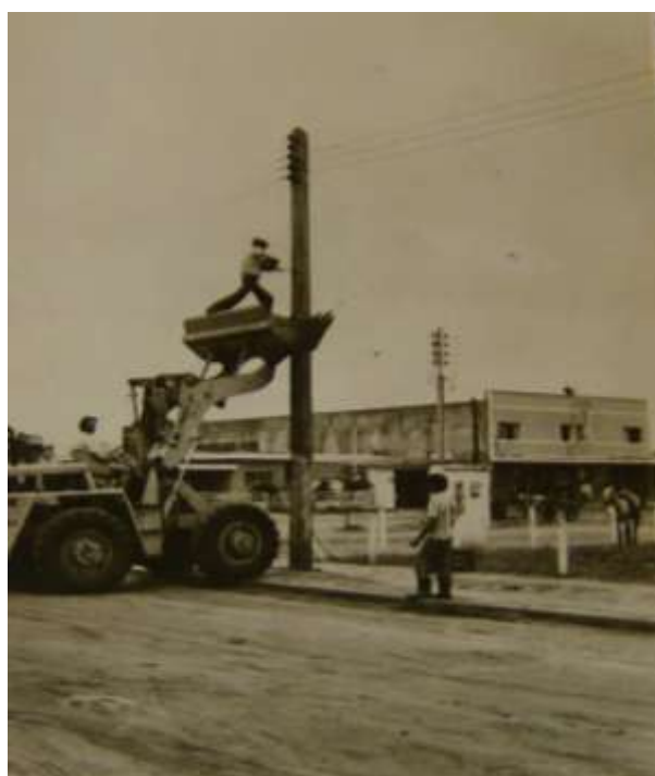
Figura 42. Iluminação Urbana. Fachada da Prefeitura, 1970.
