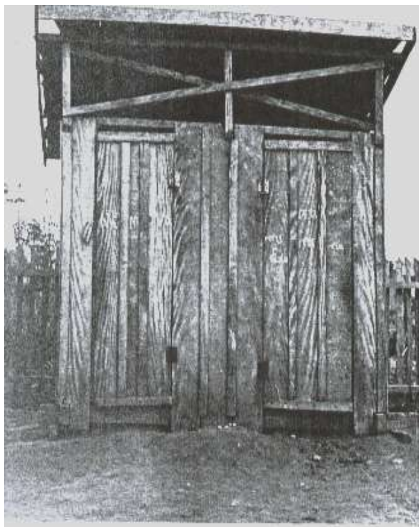
Figura 79. Banheiros de madeira do Grupo Escolar Tenente Aviador Antônio João, 1969. Fonte: Arquivo da Escola Estadual Tenente Aviador Antônio João.
