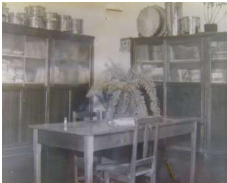
Figura 91. Biblioteca do Grupo Escolar Tenente Aviador Antônio João, 1974.
