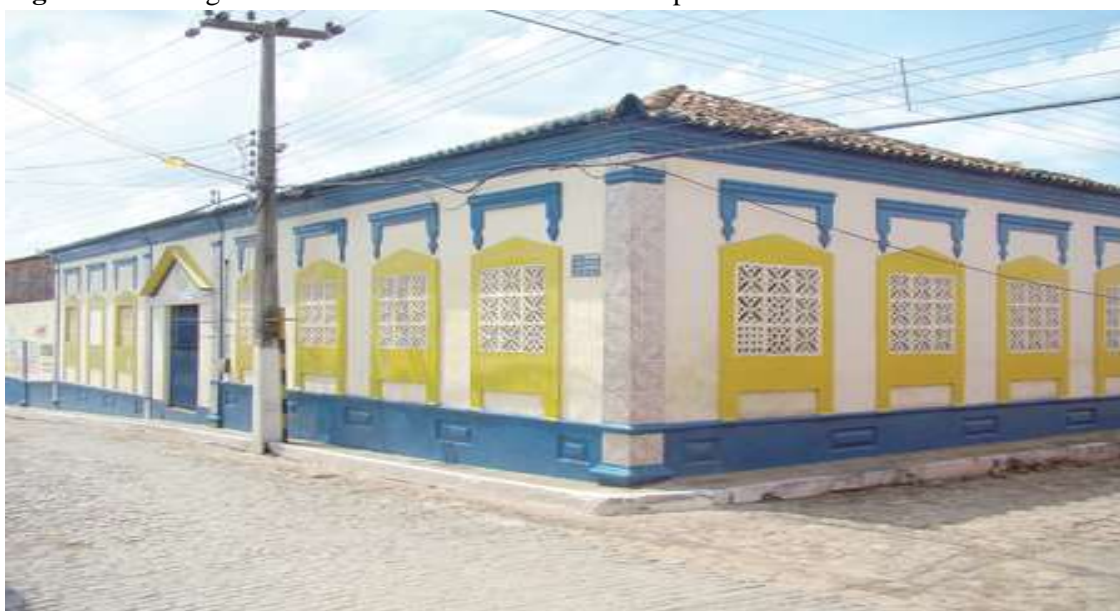
Figura 59 - Fotografia do Prédio do Ginásio Antônio Lopes em Viana-MA.
