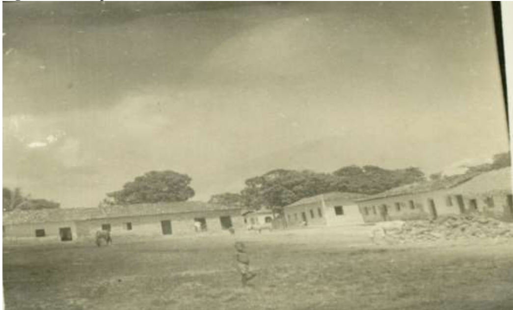
Figura 9 - Vista parcial da Cidade no ano de 1935.
