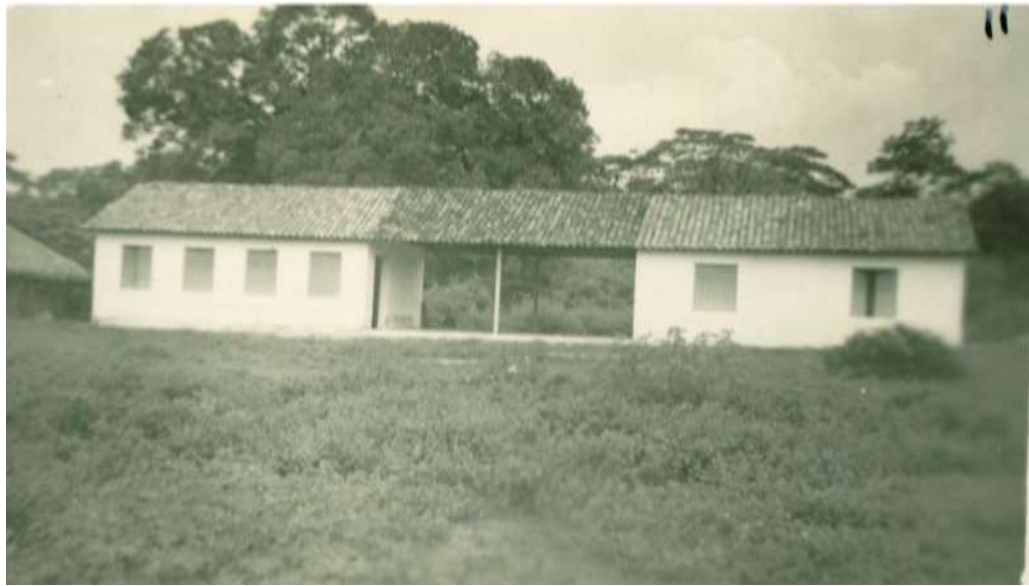
Figura 18 - Fotografia da Escola rural de Cururupu- MA, localizada no povoado quilombola de Entre Rios
