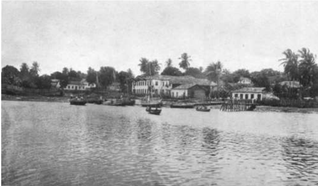
Figura 6 - Fotografia do Porto de Cururupu, no final do século XIX.
