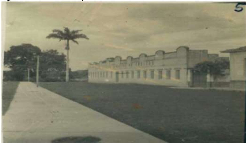
Figura 24 - Fachada do Grupo Escolar Carneiro de Freitas em Peri-Mirim-MA.
