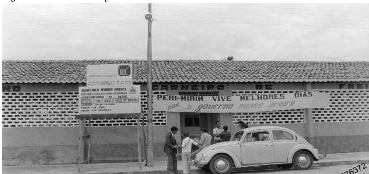
Figura 25 - Fachada do Grupo Escolar “Carneiro de Freitas” em Peri-Mirim-MA no ano de 1975.
