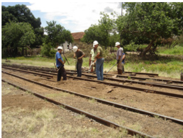
Figura 33: Acidente com ferrovia Novoeste – 2006.
