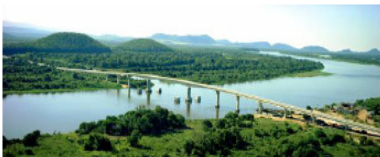
Figura 23: Ponte rodoviária e ferroviária sobre o rio Paraguai.
