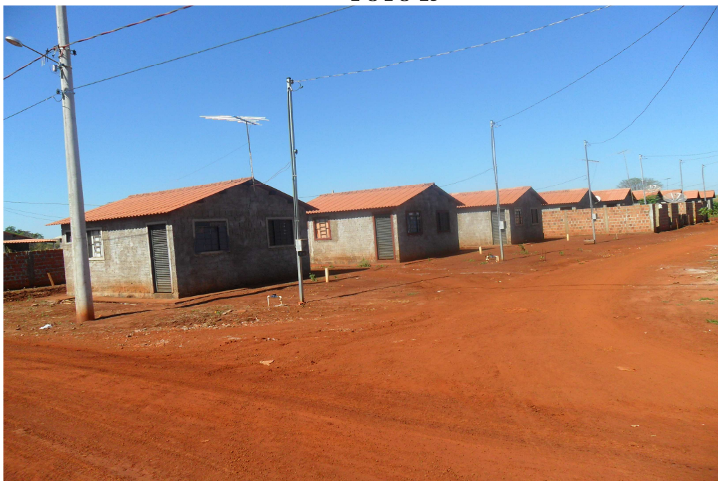
Itaporã-MS (2011) – Jardim Santa Terra Foto: Cláudio C. S. Nogueira
