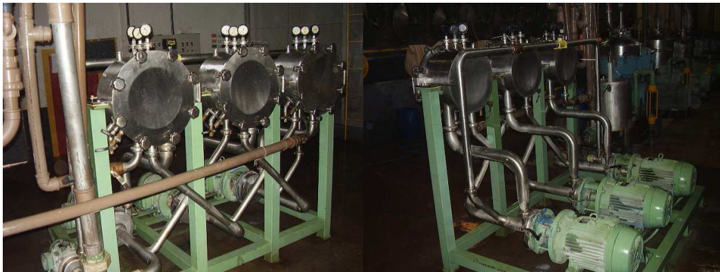
Foto 09 - Hidros utilizados para a concentração do amido (frente na foto esquerda e verso na direita)
