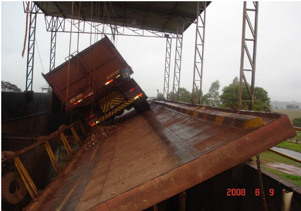
Foto 2 - Descarga do caminhão no tombador movido a um sistema hidráulico
