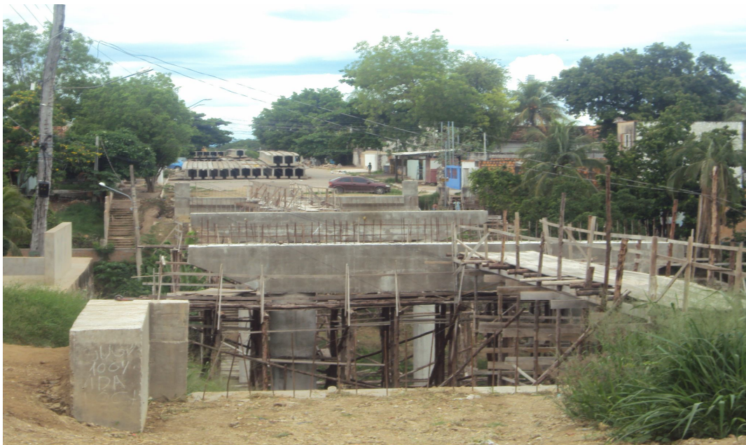
Figura nº 11 – Vigas de concreto (ao fundo) para a construção do viaduto da Rua 13 de junho
