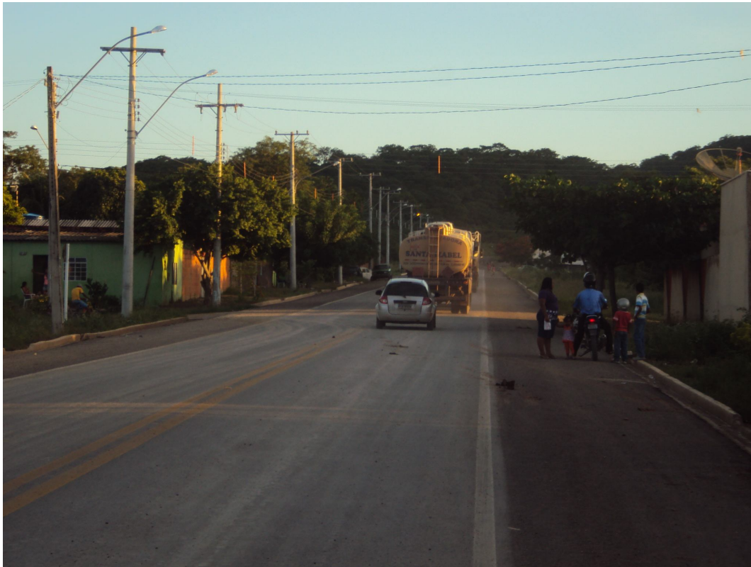
Figura nº 6 – Trecho do anel viário de Corumbá – Rua D. Pedro II
