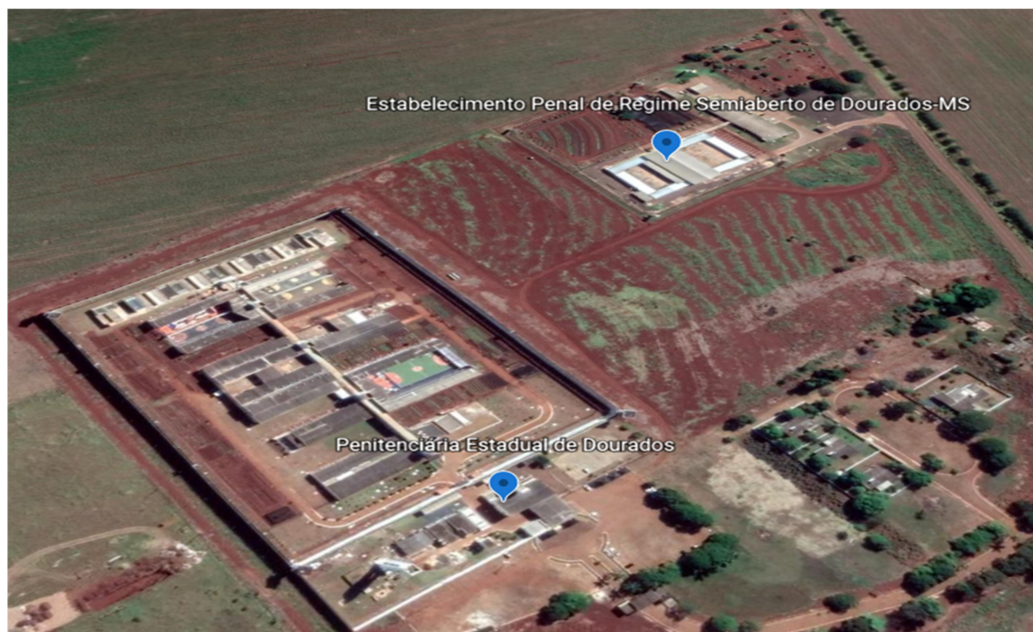
Imagem 11: Penitenciária Estadual de Dourados e Estabelecimento Penal de Regime Semiaberto, Aberto e Assistência ao Albergado de Dourados-MS por imagem via satélite.
